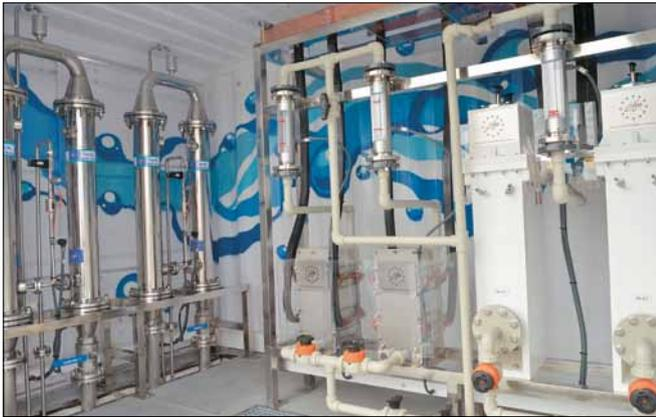
Foto 3. Interior contenedor. Tratamiento por membranas y electroquímico.
