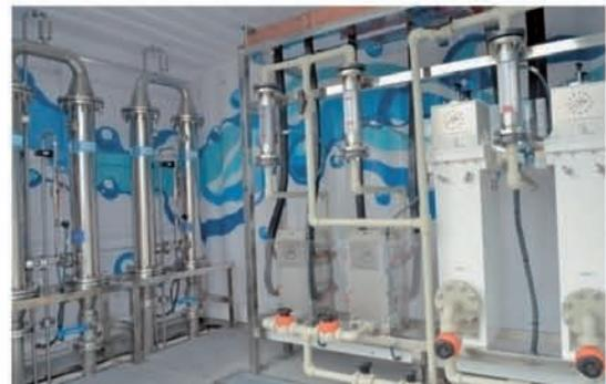
Filtración de membranas y sistema electroquímico
