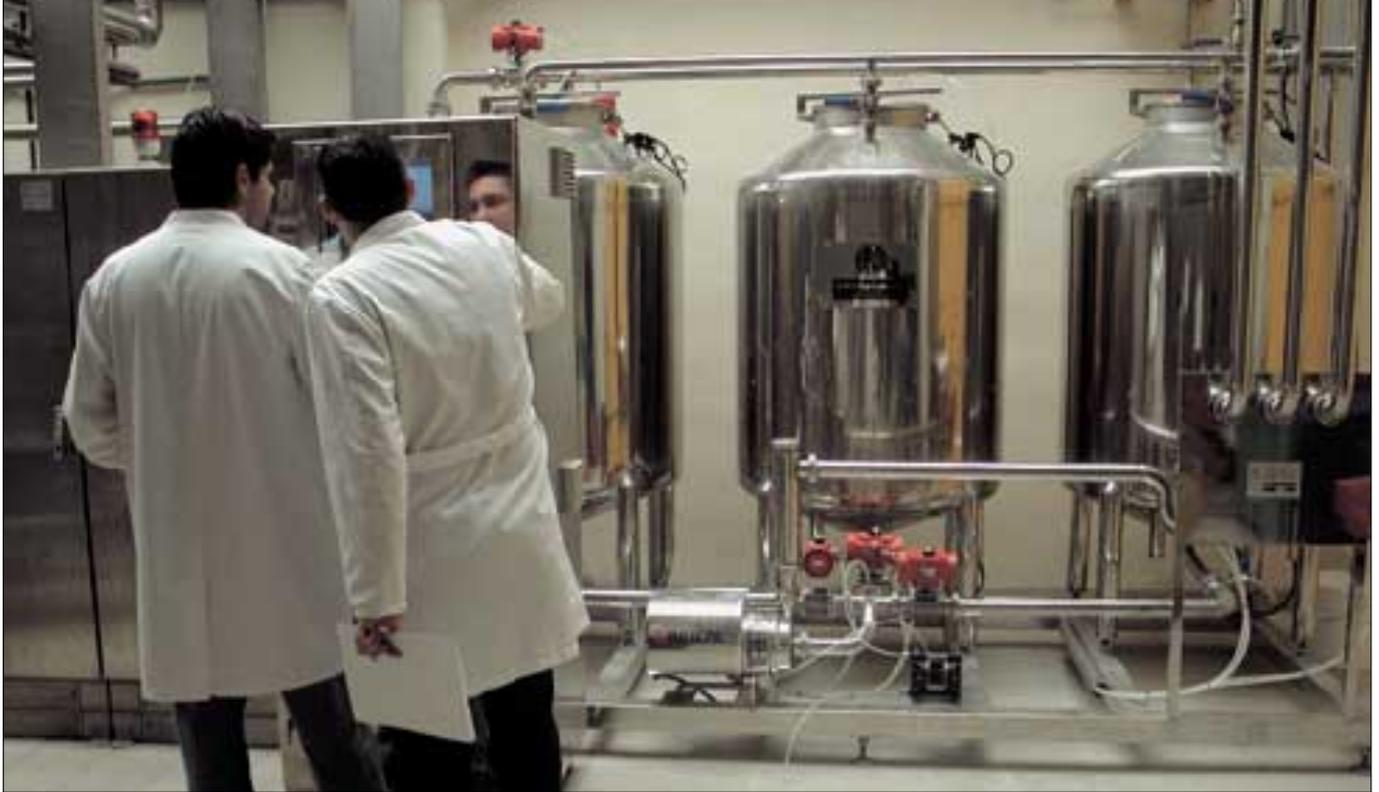
Fotografía de los tanques de limpieza C.I.P. y PC de control de la Planta Piloto.
