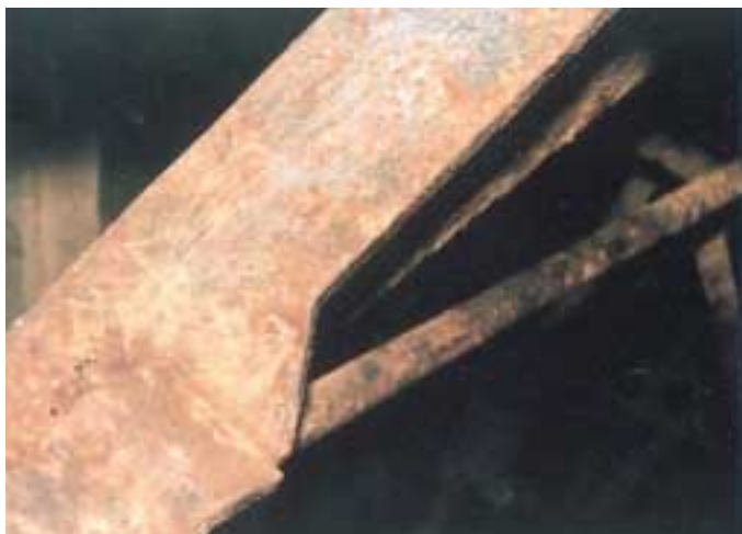
Figura 4. Detalle de corrosión en la zona de enfriamiento de un esterilizador Cooker/Cooler (zona fría, salida de envases).
