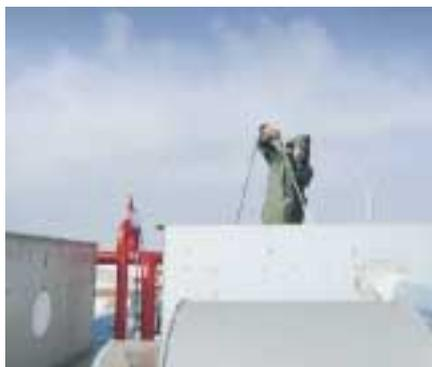
Foto 5. Desinfección condensador evaporativo.
